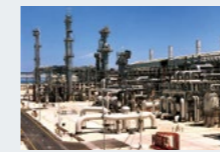
LNG project (Qatar)
